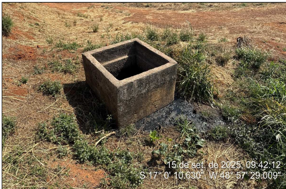
Figura 2 - Extravasamento de esgoto bruto no solo no interior da ETE por falha em caixa de passagem. Fonte: UTPA, vistoria técnica em 15/09/2025.
