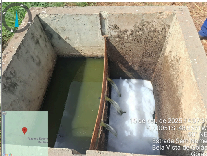
Foto 6 - Presença de Espuma em etapa do tratamento anterior ao lançamento da ETE.
