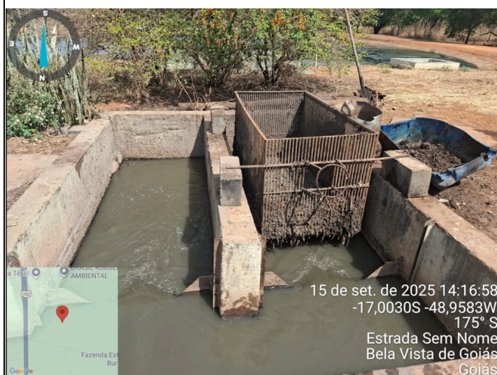
Foto 3 - Ponto de coleta do efluente bruto da ETE.
