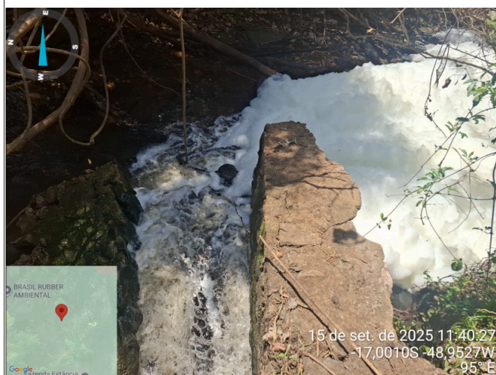
Foto 5 - Lançamento da ETE saneago com presença de espuma que se acumula no ribeirão Suçuapara.
